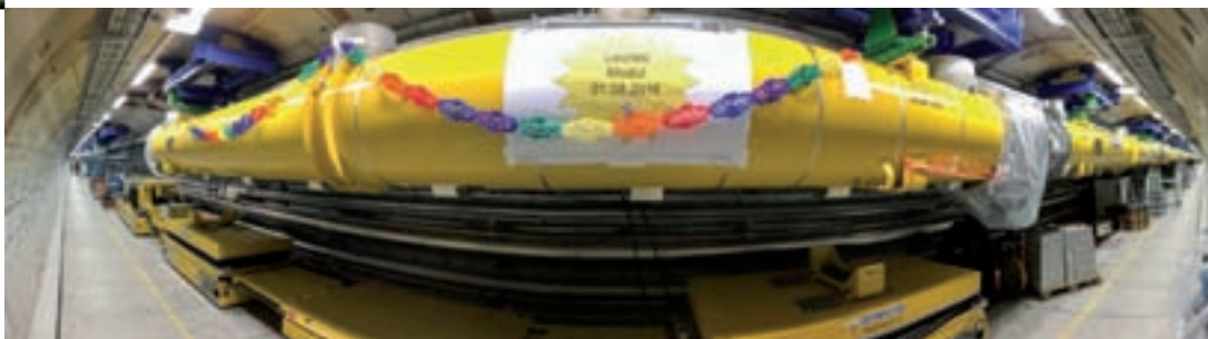
Feierstimmung: Das letzte Beschleunigermodul wurde am 1.8.2016 in den Röntgenlaser XFEL eingebaut. Die Anlage wurde in einem DESY-Tunnel errichtet, um mittels Teilchenbeschleunigung Röntgenblitze zu erzeugen. Die Anlage soll 2017 in Betrieb gehen, als eine der stärksten Röntgenquellen weltweit
