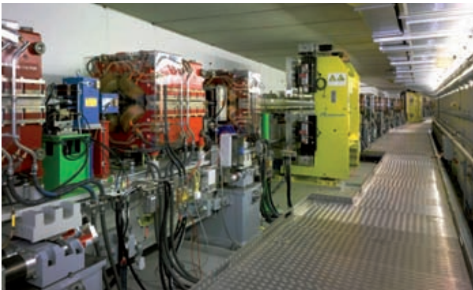
Blick entlang des Speicherrings PETRA III mit Ablenkmagneten (blau), Fokussiermagneten (rot) und Undulatoren (gelb) im Bereich der Experimentierhalle
