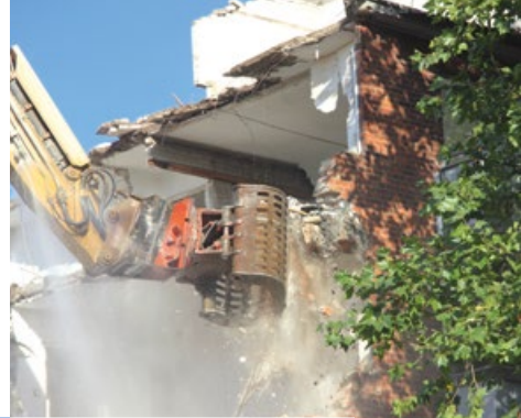
Neue Perspektive nach dem Abbruch: der Kreuzungsbereich Bramfelder Straße und Lämmersiech.
