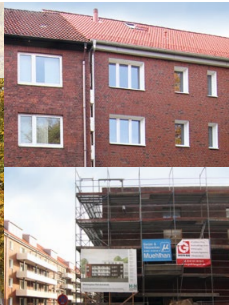
Der erste Bauabschnitt ist geschafft: Bis voraussichtlich 2024 wird das Quartier Bürgerweide durch Modernisierung und Neubau umgestaltet.
