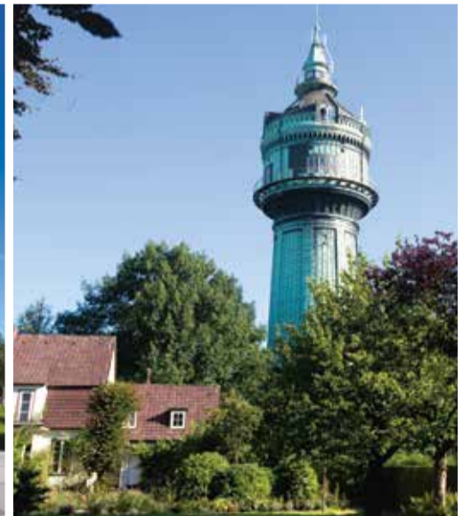
Wahrzeichen Lokstedts: Der Wasserturm in der Sülfeldstraße wurde 1911 errichtet und diente zum Druckausgleich und als Reserve für die Lokstedter Wasserversorgung. Bereits 1891 ging den Lokstedtern ein Licht auf – Lokstedt war das erste Dorf in Deutschland mit elektrischer Straßenbeleuchtung.
