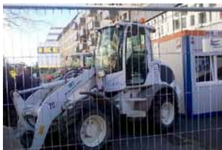
DIE BAUARBEITEN BEGINNEN!
