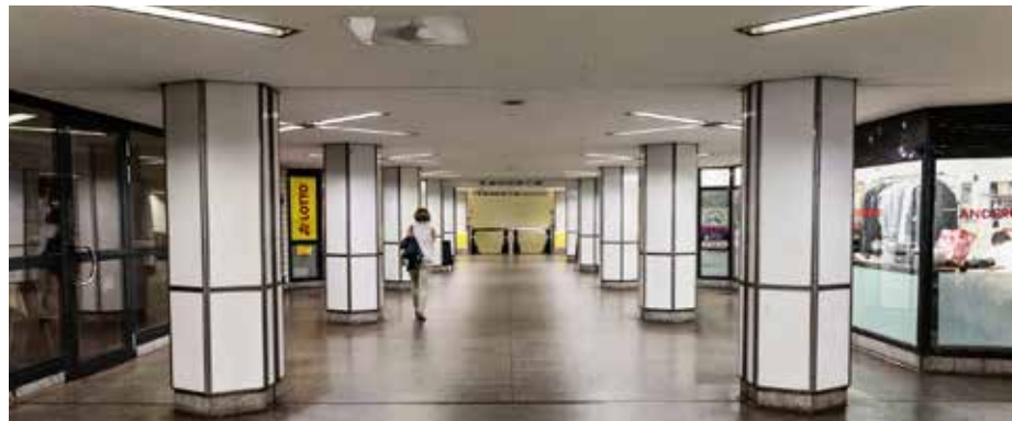
Hell und freundlich, wie hier im Eingang Alstertor des Bahnhofs Jungfernstieg, sollen Zwischenebenen gestaltet sein.
