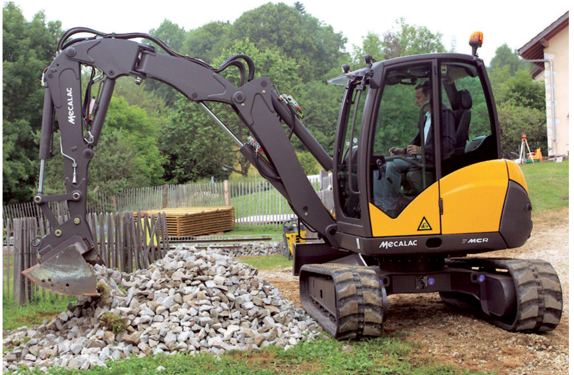
(Foto: MECALAC Baumaschinen GmbH)
