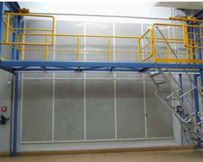
Abbildung 4/8: Sicherung des Zugangs zur Dacharbeitsebene
