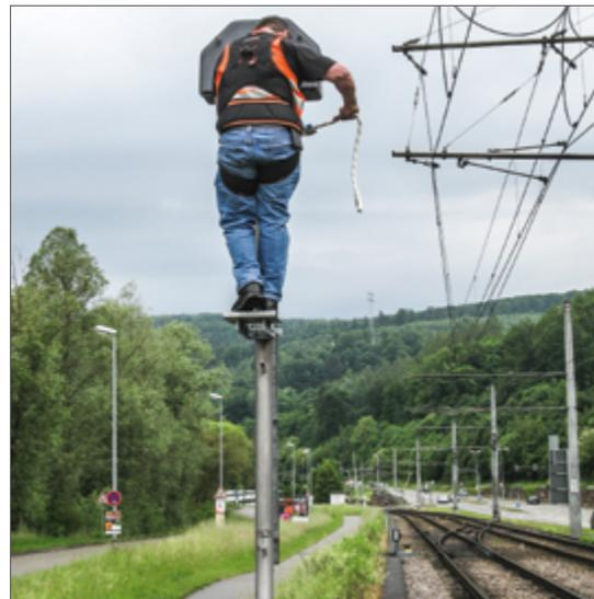
Auch bei Bauarbeiten und sonstigen nichtelektrotechnischen Arbeiten in der Nähe von Fahrleitungsanlagen ist grundsätzlich zu prüfen, ob diese während der Arbeiten spannungsfrei gemacht werden können. Ist dies nicht möglich, müssen grundsätzlich folgende Schutzabstände auch mit Geräten und Hilfsmitteln jederzeit eingehalten werden (vergleiche DIN VDE 0105-100):
