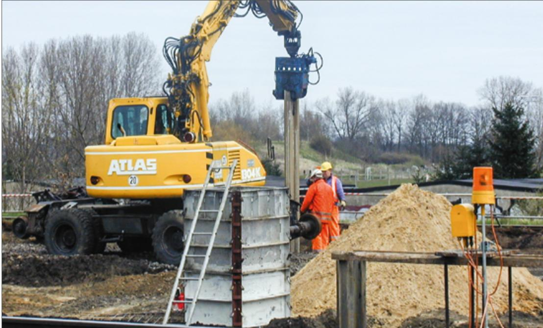
Abbildung 21: Auch auf Baustellen ist grundsätzlich mit Arbeitsmitteln und Arbeitsgegenständen, zum Beispiel Leitern, Schalungen, ein Mindestabstand zur Gleismitte von 2,2 m beziehungsweise bei Fahrgeschwindigkeiten über 30 km/h von 2,4 m einzuhalten.
