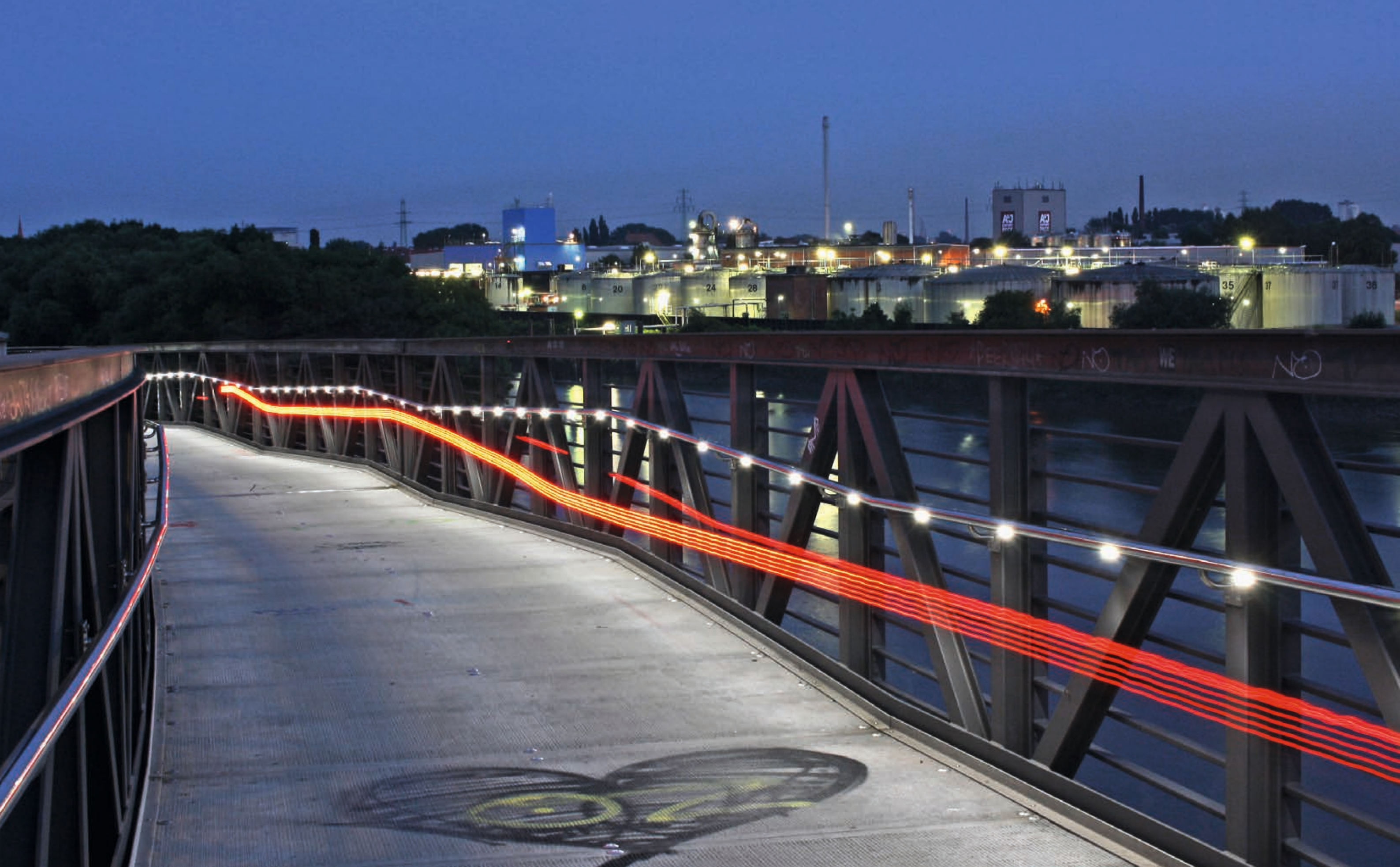
Klütjenfelder Geh- und Radwegbrücke
