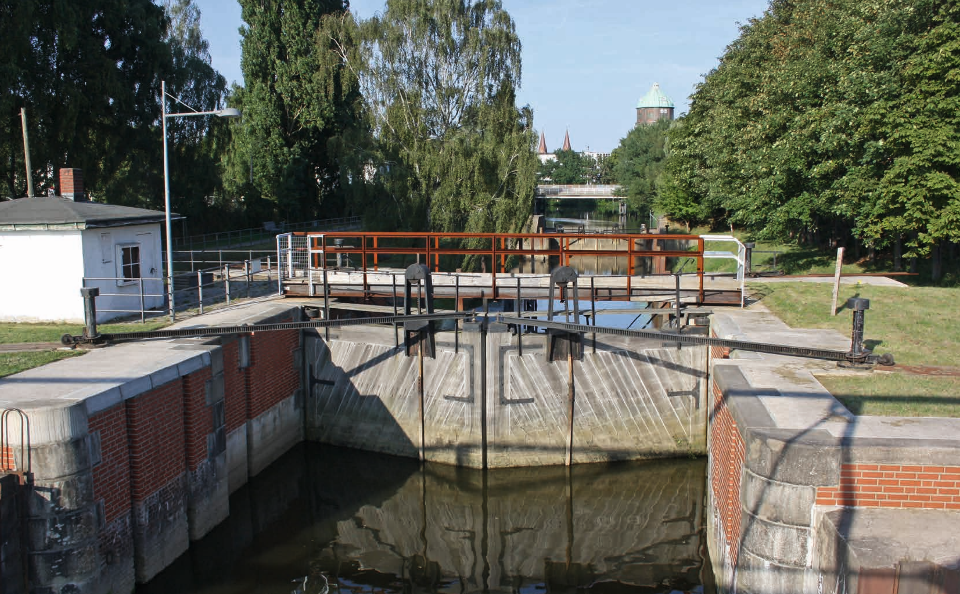
Alte Schleuse im Veringkanal
