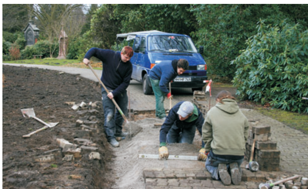
Auszubildende bei der Ausbesserung eines Gürtelweges um den Rosengarten. Auf der Fläche links im Bild entsteht wenig später der Ohlsdorfer Rosenhain, eine im Jahr 2008 eröffnete neue Themen-Anlage
