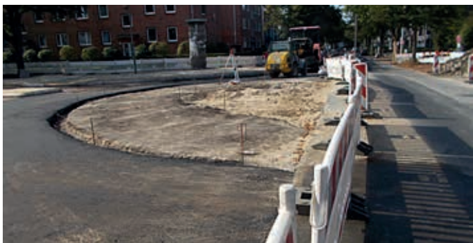
Der südliche Teil des Kreisels
