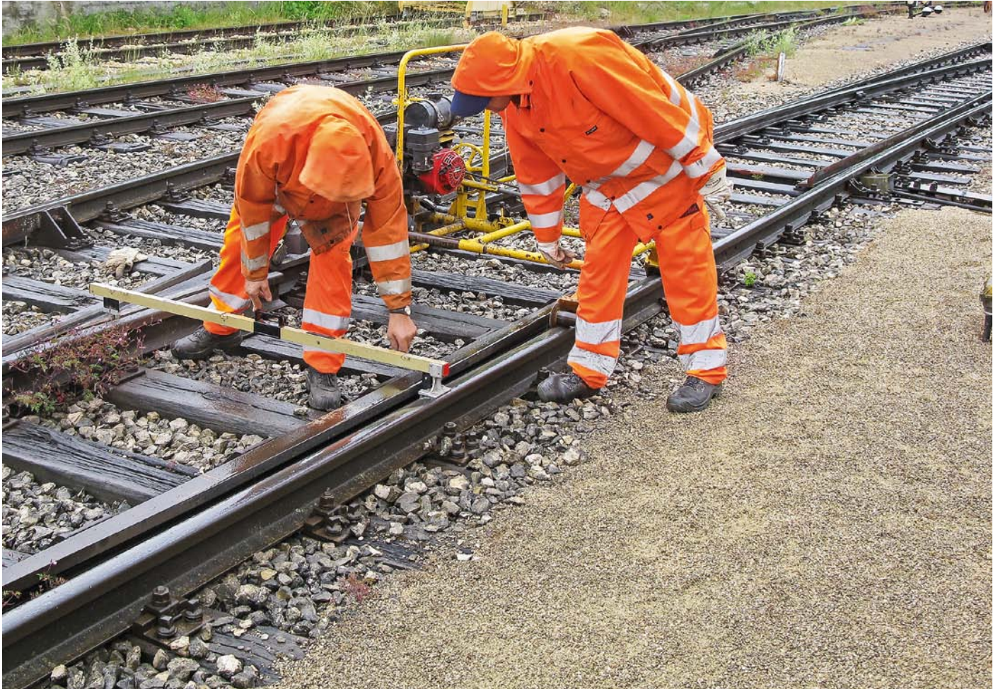
Für diese Tätigkeit wurde das Gleis gesperrt.
