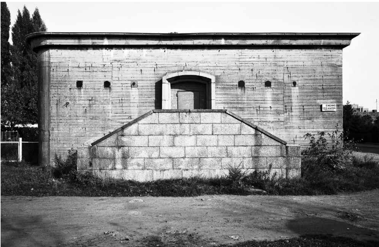
Stephanstraße 133, Hamburg-Wandsbek (2009 abgerissen)
