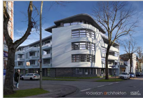
© roderjan architekten hamburg-dresden
