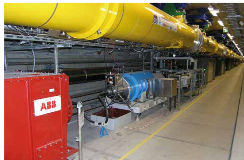
Anders als in anderen DESY-Beschleunigertunneln hängen die Module des European XFEL unter der Decke. Bild: DESY, Michael Bousonville
