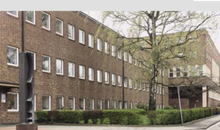
Dienstgebäude in Kiel
