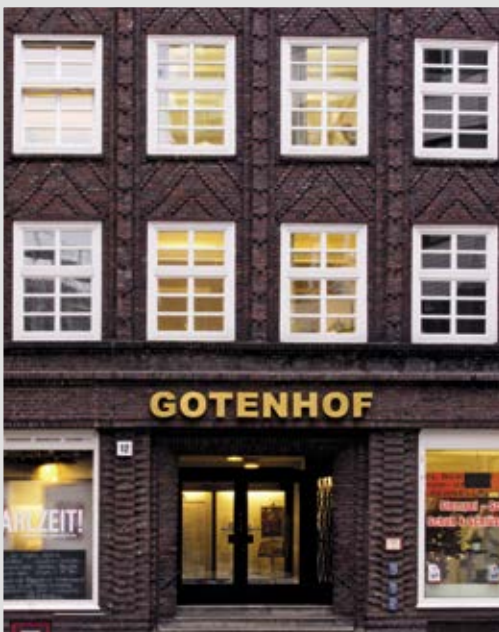
Dienstgebäude in Hamburg, Eingangsbereich
