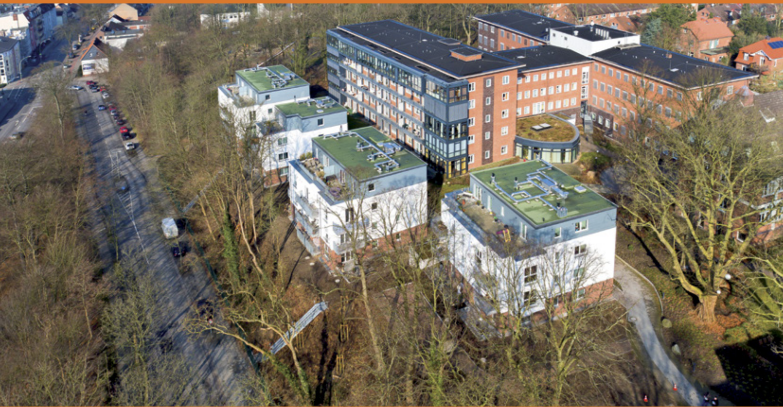
Die „Gojenbergsvillen“ in Bergedorf, dahinter die Gebäude des ehemaligen Allgemeinen Krankenhauses Bergedorf. Rechts im Bild der alte Baumbestand des ehemaligen Patientengartens – heute denkmalgeschützt.
