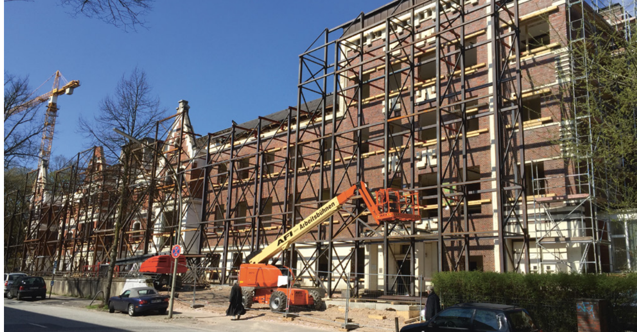
Die Fassade des ehemaligen Krankenhauses wird durch ein Gerüst gestützt und anschließend wieder an dem Gebäude befestigt
