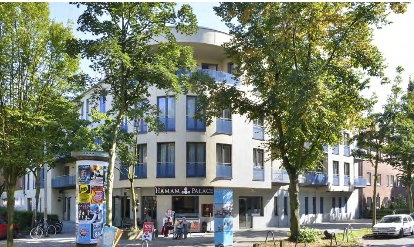
Abb. 1: Der Neubau kurz nach Eröffnung im Dezember 2012 (Nordwestansicht aus der Veringstraße)
