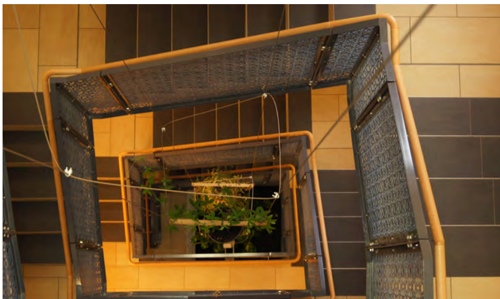
Abb. 21: Blick in das zentrale Treppenhaus
