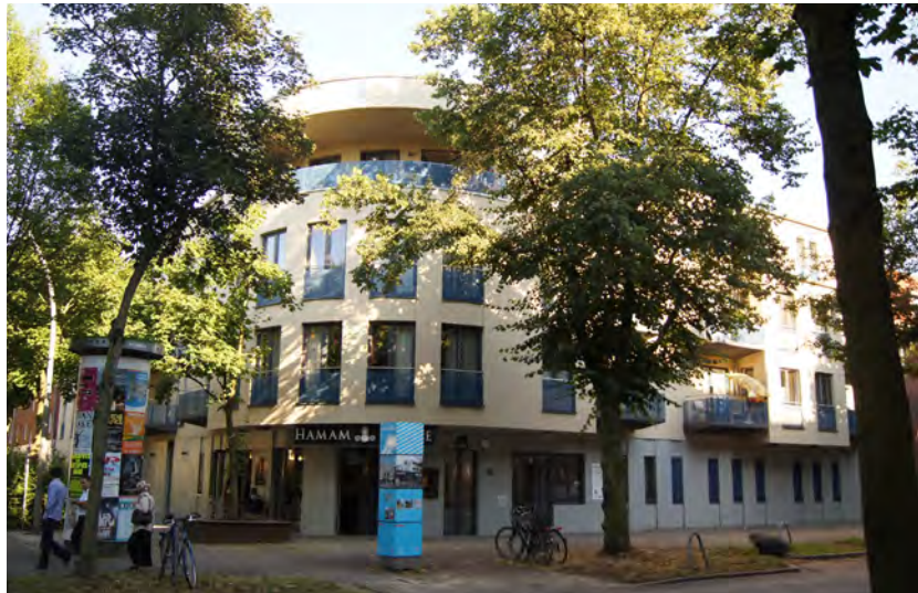
Abb. 54: Eckansicht aus der Veringstraße
