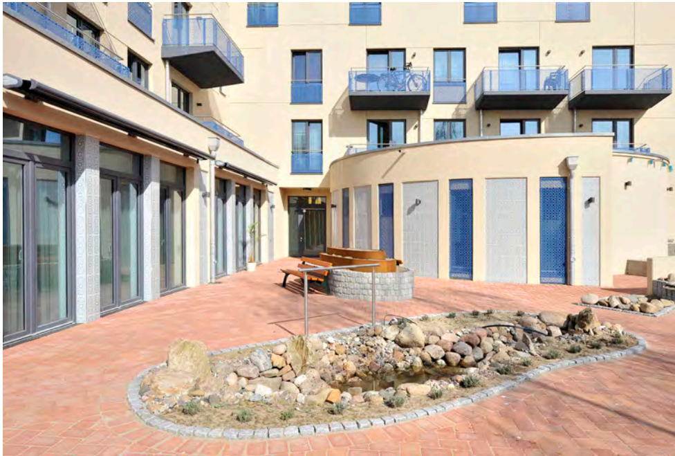
Abb. 2: Rückseite des Gebäudes mit Gartenhof und Hamambereich (runder Gebäudeteil)
