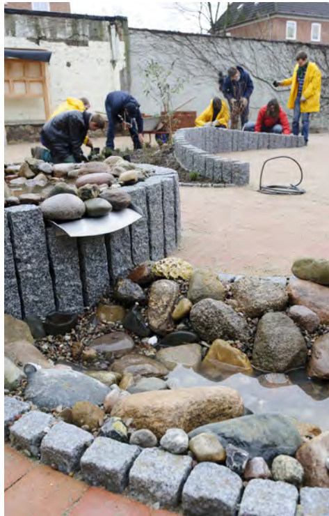
Abb. 29: Arbeiten hinter dem fertigen Bachlauf
