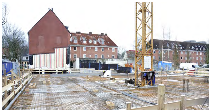
Abb. 26: Baustelle im Dezember 2010
