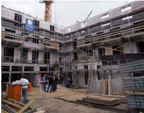
Abb. 27: Baustelle zum Richtfest (Juni 2011)
