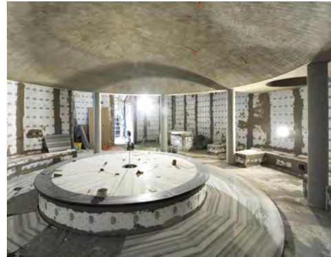
Abb. 28: Hamam im Rohbau
