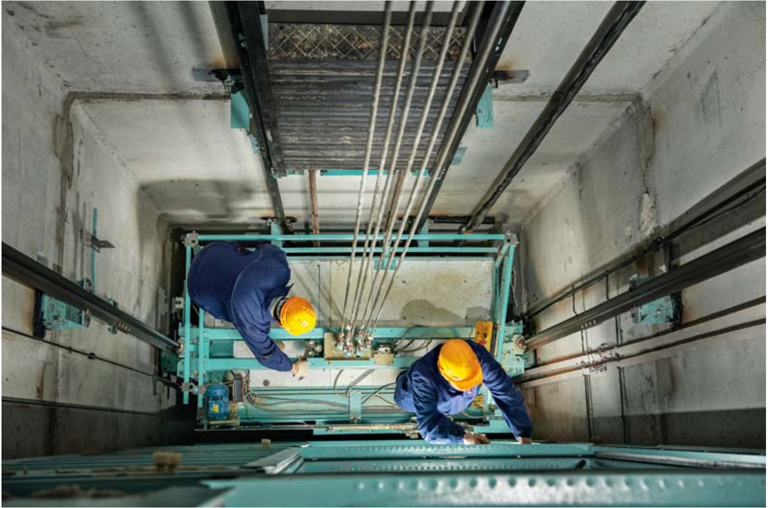
Für jeden Aufzug muss der Betreiber einen Notfallplan erstellen.
