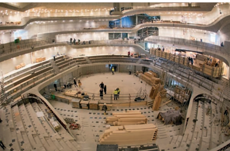
der Konzertsaal im Rohbau
