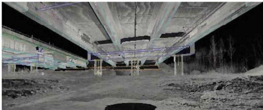
Visualisierung der Scanaufnahme und CAD der Bauelemente
