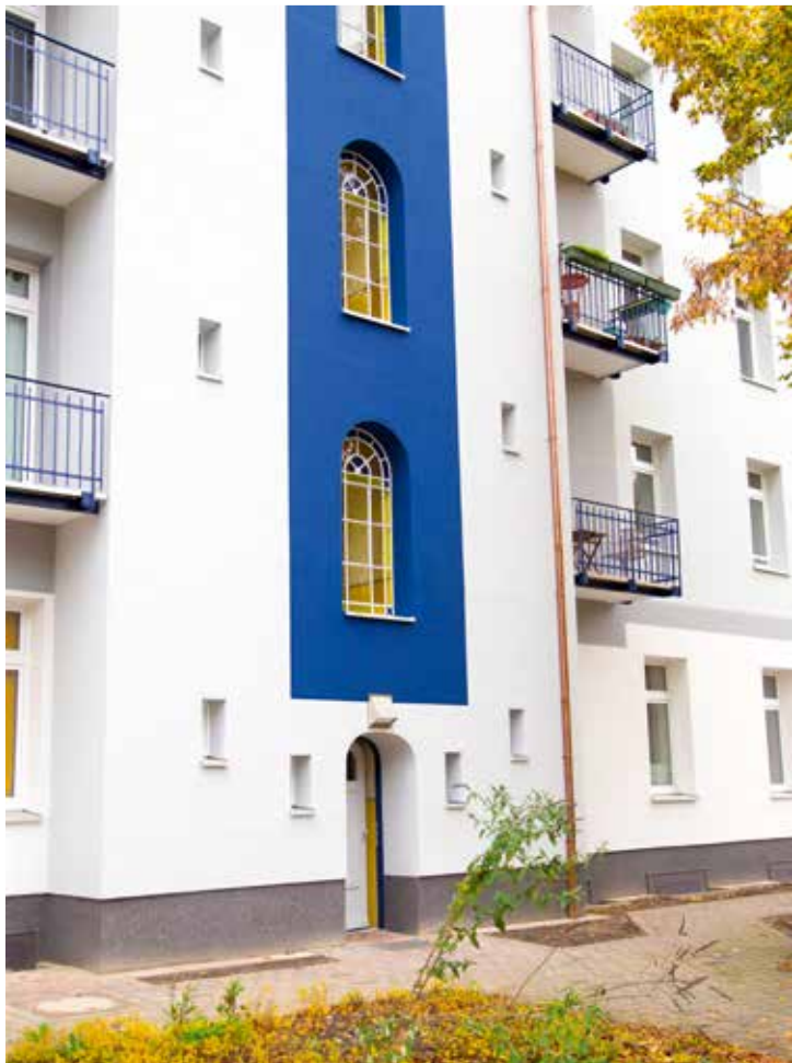
Die Rückseite der Fährstraße 66-72 wurde aufwändig energetisch modernisiert.
