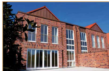
Exklusive Neubau-Mietwohnungen in Bestlage von Wellingsbüttel
