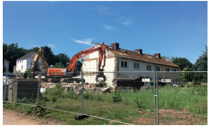
Die Nachkriegsreihenhäuser von 1954 werden abgerissen
