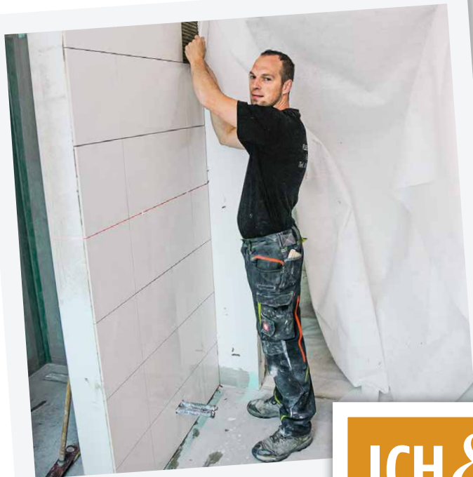
Fliesenlegermeister André Schiller bei der Arbeit auf der Baustelle.
