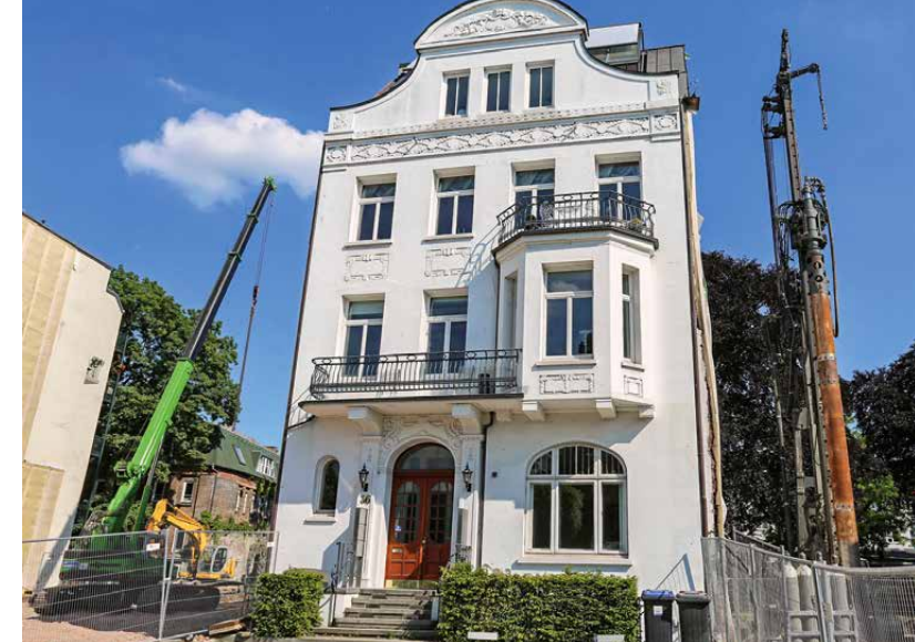
Innerstädtische Baulücken wie hier an der Außenalster in Hamburg sollen leichter für den Wohnungsbau genutzt werden können.
