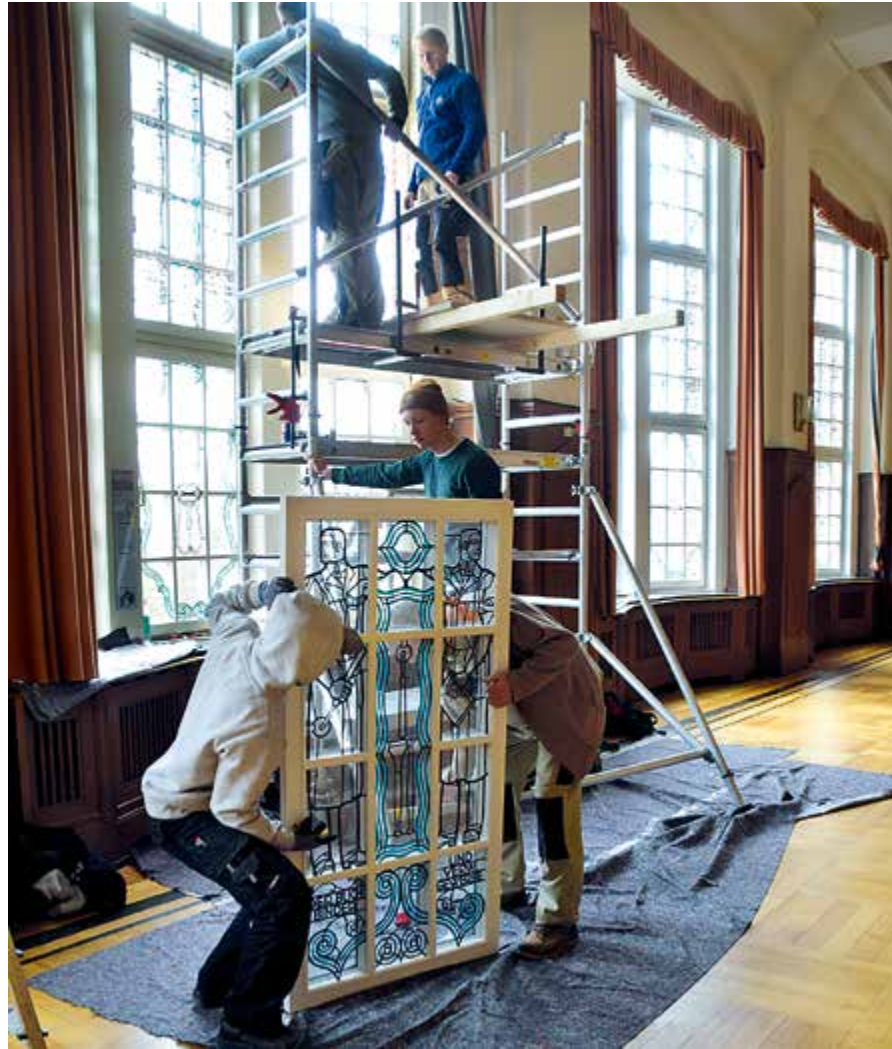
Kraft und Umsicht sind beim Einbau der wertvollen Bleiglasfenster gefordert. Hier kehren der Buchbinder und verwandte Gewerbe an ihren ursprünglichen Platz zurück.
