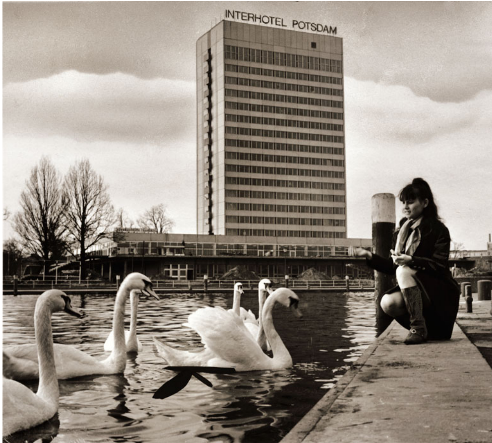
Interhotel in Potsdam 1969 (heute Mercure-Hotel): „Notdurft-Architektur“
