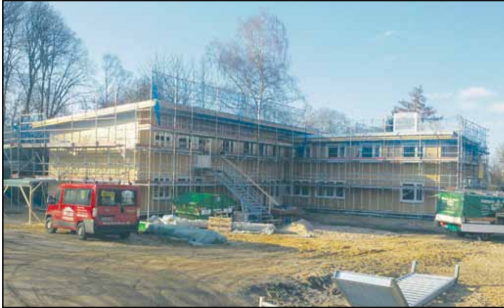
Die neue Erstversorgung Krausestraße wird zum 1. April in Betrieb genommen. Das Gebäude in Holzrahmenbauweise bietet elf Zimmer für 28 Jugendliche sowie zwei Aufenthaltsräume, Küchen und Sanitärräume, darüber hinaus Räume für Büros und Besprechungen. Foto: Kagelmann
