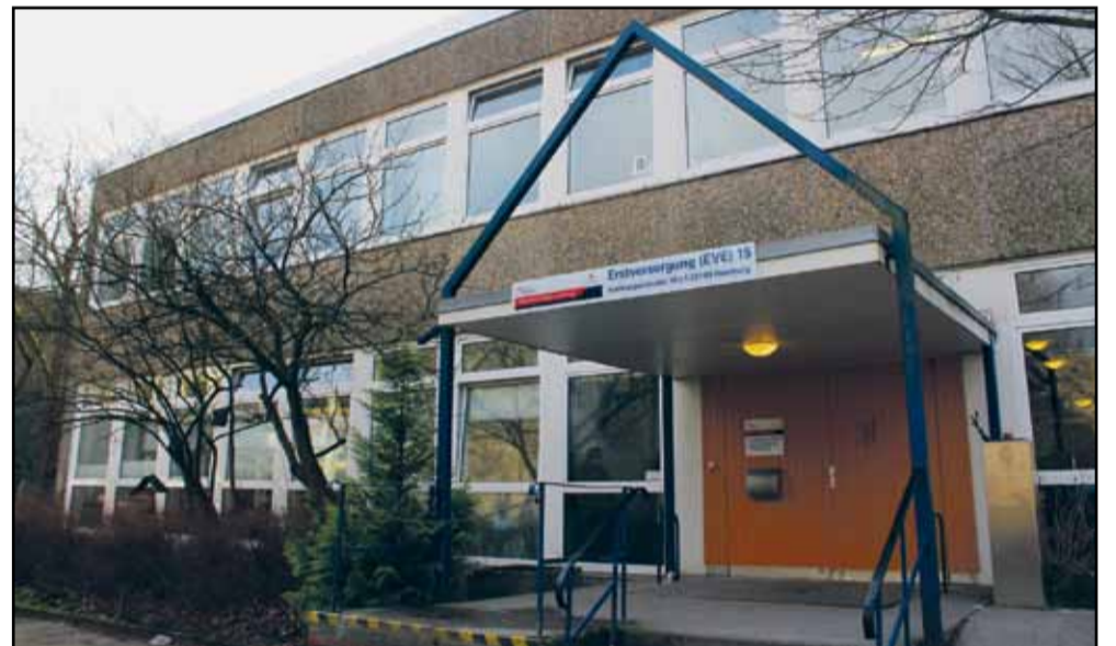
Im Oktober 2015 wurde die Erstversorgung 15 auf dem Gelände der Schule Kielkoppelstraße mit zunächst 32 Plätzen in Betrieb genommen. Nach dem Umbau der zweiten Etage bietet die Einrichtung insgesamt 80 Plätze für unbegleitete minderjährige Flüchtlinge.
