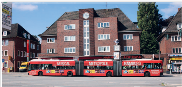
Schneller am Ziel Im Rahmen der Busbeschleunigung wurde der Siemersplatz für knapp vier Millionen Euro ausgebaut
