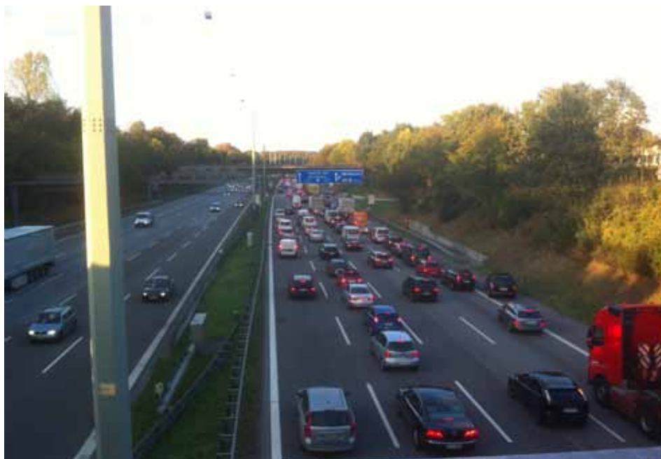
Die Autobahn 7 zerschneidet seit langem den Stadtteil Bahrenfeld und sorgt durch häufigen Stau für Abgase und Lärm. Foto: Bernt Grabow
