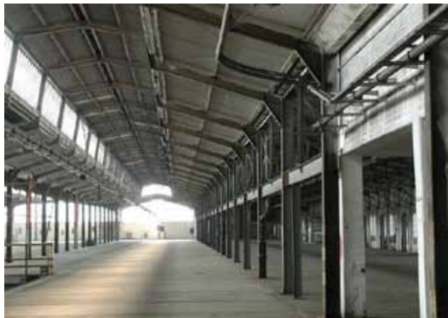
Blick in eine alte Halle auf dem Bahngelände an der Harkortstraße.
