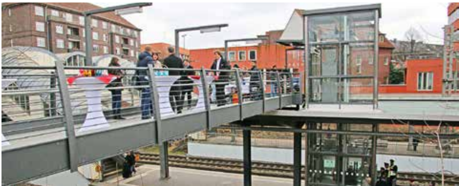
Der neue Aufzug verbindet den Bahnsteig mit der Fußgängerbrücke.
