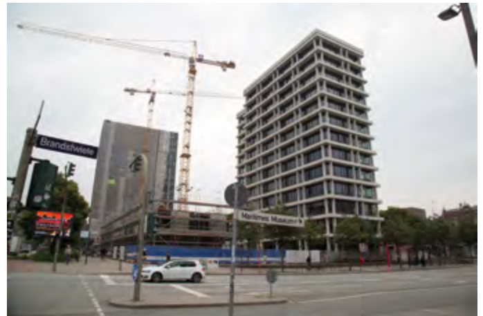
Die Umbauzeit des Hochhauses dauerte zwei Jahre
