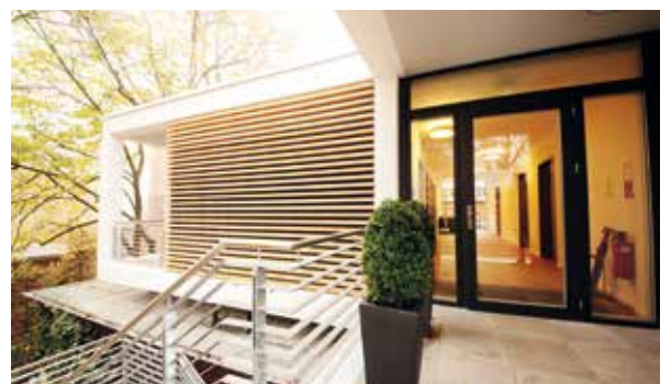
Der Eingangsbereich des UHZ-Baumhauses
