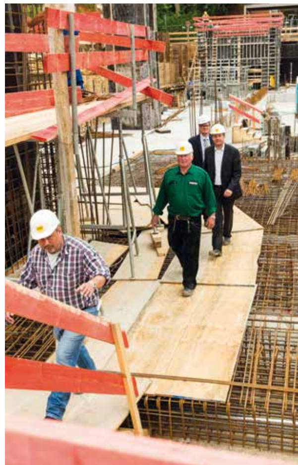
Das Team des Generalunternehmers Züblin sorgt für die fristgerechte Umsetzung der Pläne
