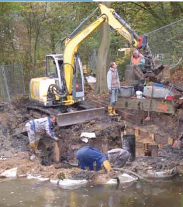
Für den neuen Messcontainer musste der Außenbereich der Station erweitert und gegen Hochwasser gesichert werden.
