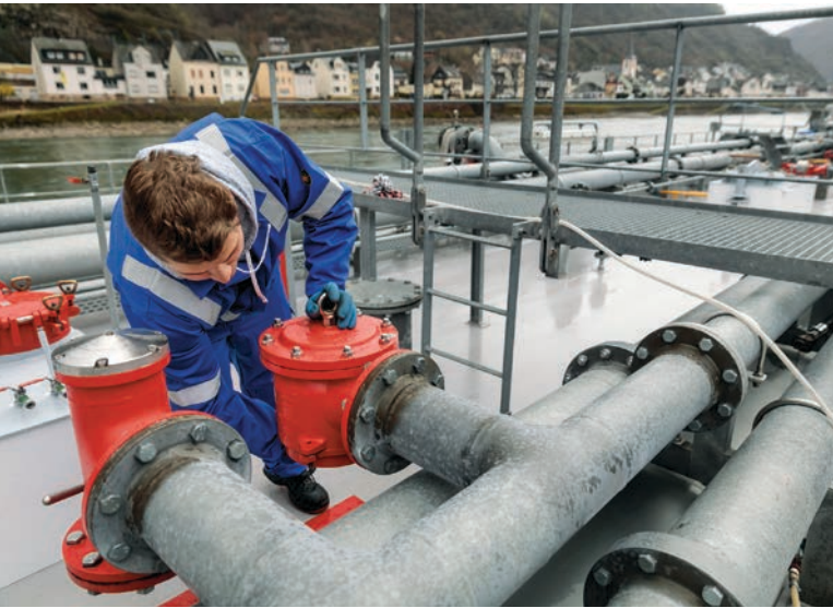
Manuel Hartmann bringt die Auffangbehälter in Position.
