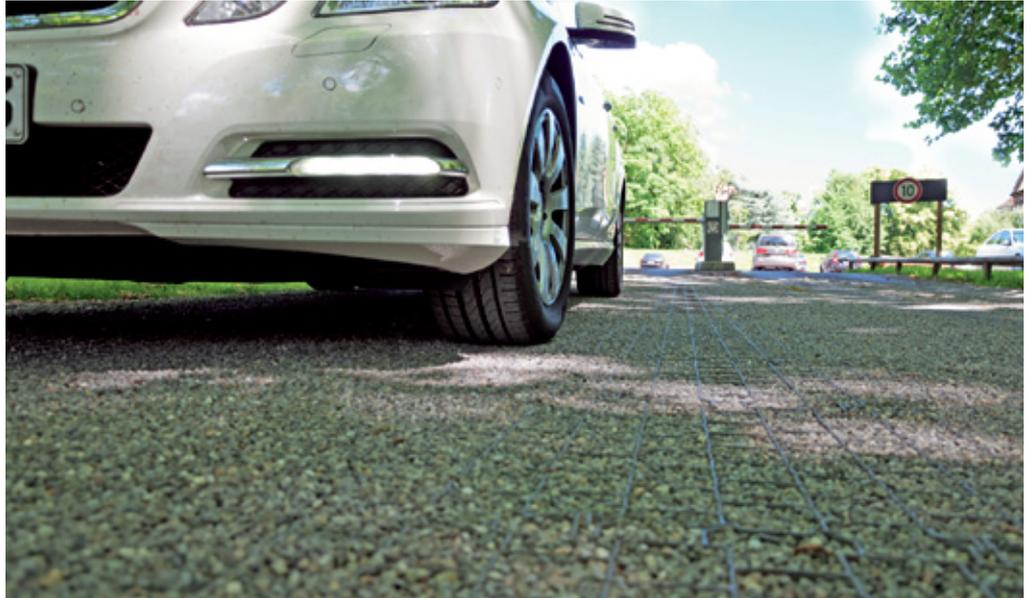
GravelGrid hält das Schüttgut dauerhaft wasserdurchlässig sowie barrierefrei begeh- und befahrbar. (Foto: Ritter GmbH)
