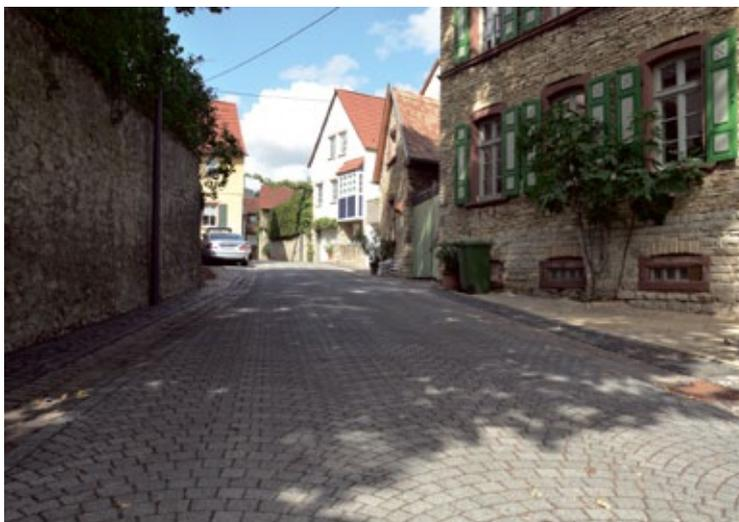
*Nachher: Das Segmentbogenpflaster ArcoStrada verbindet die attraktive Optik eines Kleinpflasters mit den Vorteilen eines gut begehbaren und belastbaren Betonpflasters. (Foto: Betonwerk Pfenning GmbH)*
