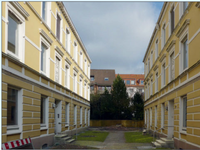
Die leer stehenden Terrassenhäuser in der Josephstraße sollten abgerissen werden. Fotos: Thorsten Richter
