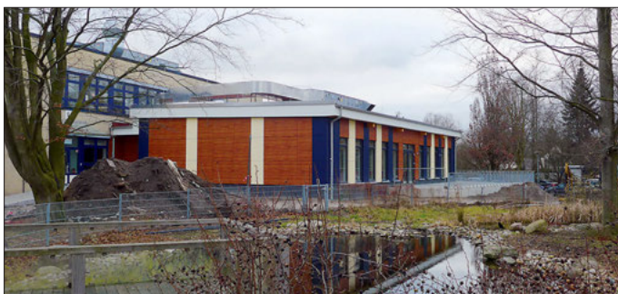
Der Mensa-Anbau, Blick von der Jenfelder Allee. Foto: Thorsten Richter
