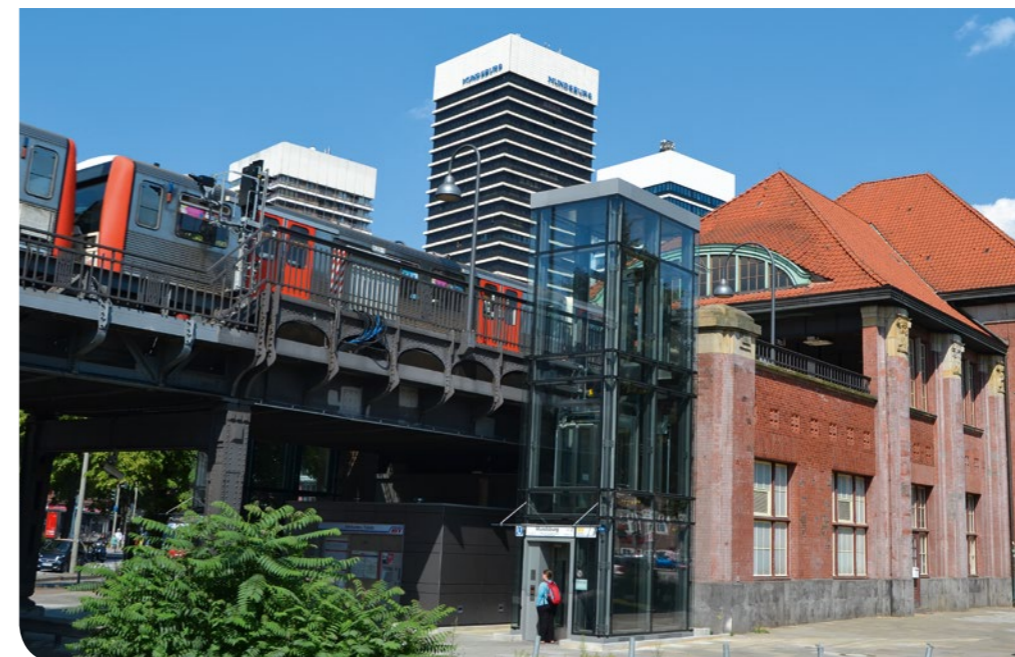
Barrierefreiheit hergestellt: Der U-Bahnhof Mundsburg erhielt 2014/15 Aufzüge und ein Leitsystem für Sehbehinderte
