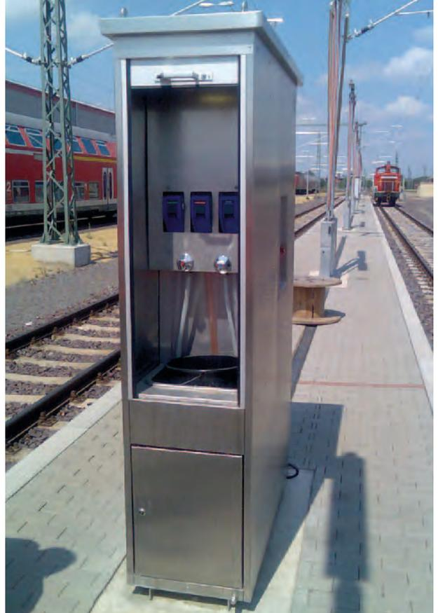
An dieser Dosierstation kann eine fertig ange-mischte Reinigungslösung entnommen werden.
