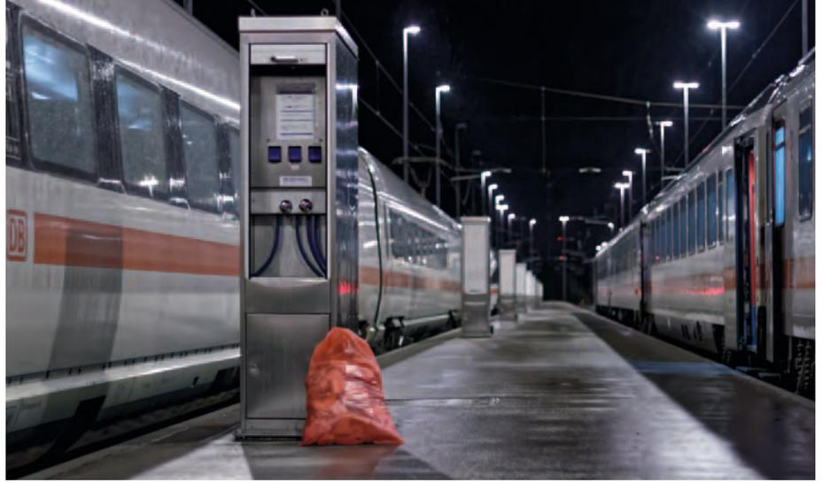
Das Tragen von Lasten über lange Strecken kann reduziert werden, wenn die Medienentnahmestellen in kurzen Abständen (maximal 50 Meter) aufgestellt werden.
