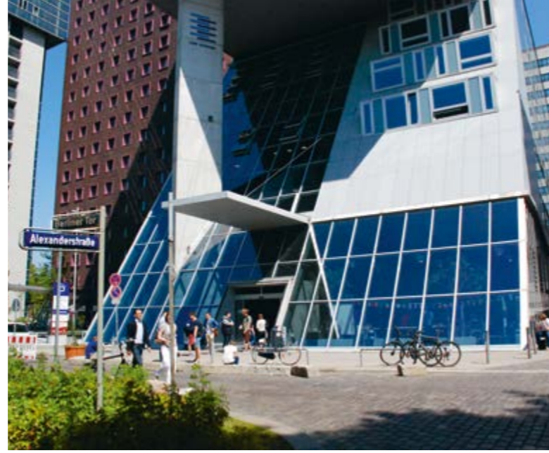
Hauptgebäude der HAW am Berliner Tor
