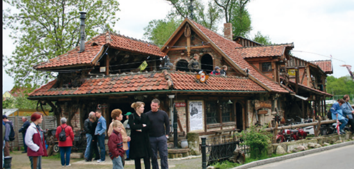
Die Fachwerkbauten der Bike Schmiede wurden liebevoll restauriert.
