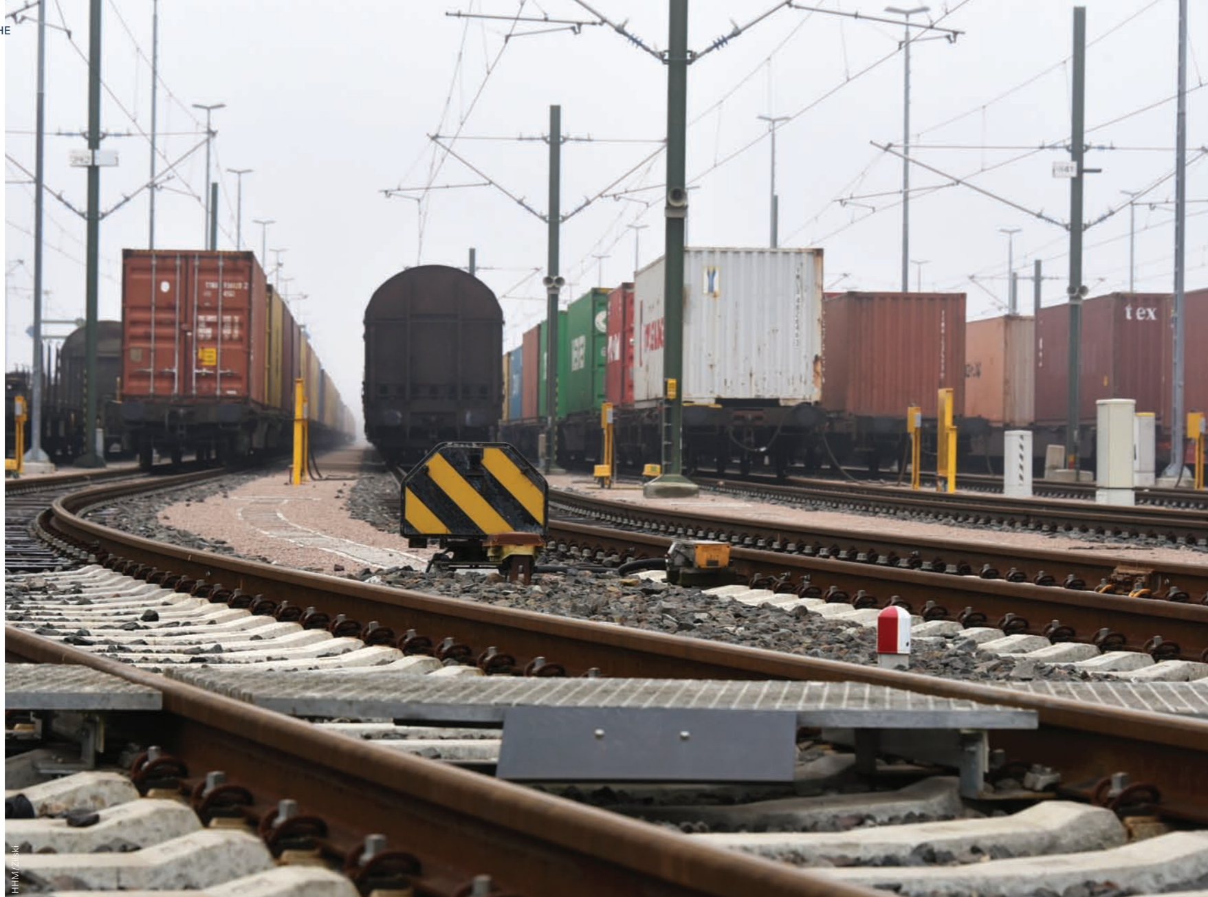
Der Rangierbahnhof Maschen verfügt über insgesamt 88 Gleise zur Zugbildung und -kontrolle.
