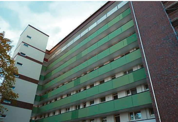
Der erste Bauabschnitt am Heidrehmen ist abgeschlossen und an der Hausnummer 29 kommt die neue Fassade in attraktiver Optik zum Vorschein
