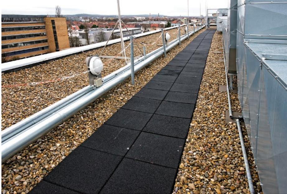
Sicherheit vom Feinsten: Auf diesem Flachdach gibt es für die Techniker breite Wege aus rutschsicheren und dämpfenden Gummimatten, stabile Trittleitern mit Handläufen und sauber verlegte Laufgitter und bei Bedarf auch eine Beleuchtung.
