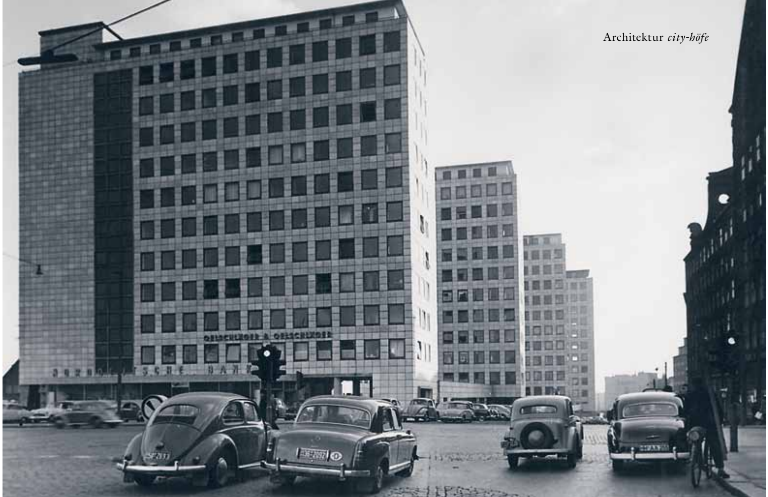
Das Hochhaus-Ensemble, wie es sich kurz nach seiner Fertigstellung Ende der 1950er Jahre präsentierte
