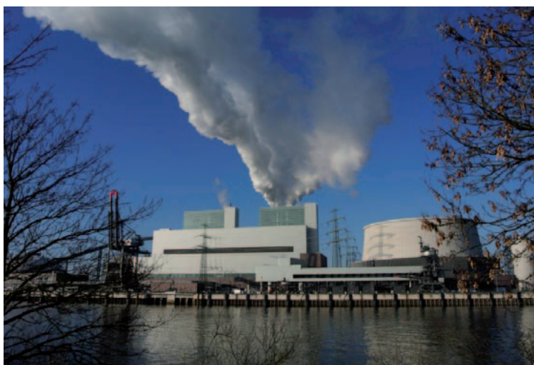
Bild 2: Wasserdampfwolke des Kraftwerkes Moorburg gegen den blauen Himmel
